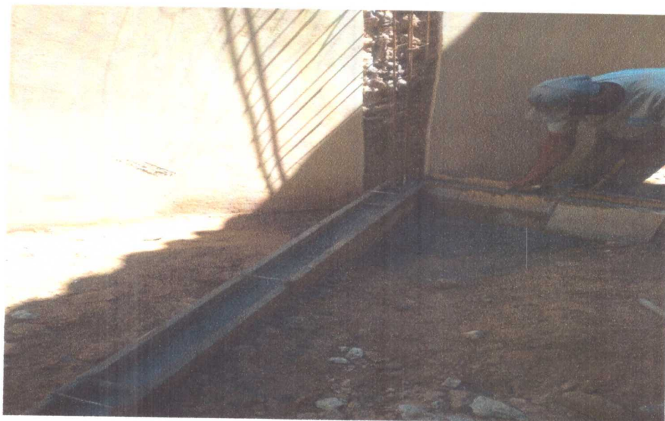
FORMA & CONCRETAGEM FUNDAÇÃO DA DESPENSA
